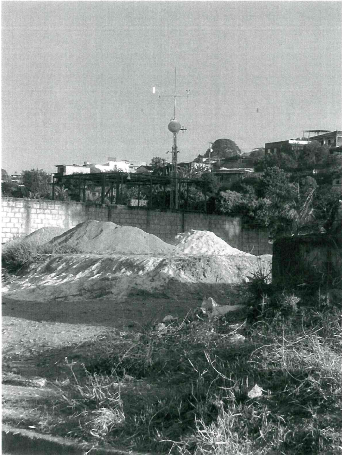
Imagem 4 – Presença de depósito de areia próximo da estação
